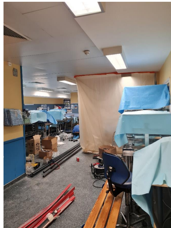
Réfection des réseaux d'alimentation des laveurs-désinfecteurs
